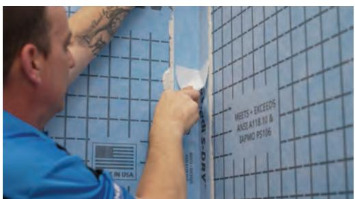
La instalación de la membrana de pared se puede realizar con wedi® S-DRY™ y wedi® S-DRY™ XL. Las juntas se pueden sellar con cinta adhesiva o solapar y impermeabilizar activamente y unir con wedi® S-DRY™ SEAL.
