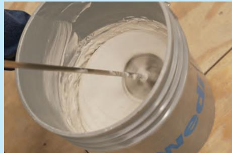
Las juntas de yeso con forma cónica natural deben prepararse con wedi® PRO-SET™ o con un material de reparación adecuado para garantizar que la membrana acabada se instale sobre un sustrato plano.
