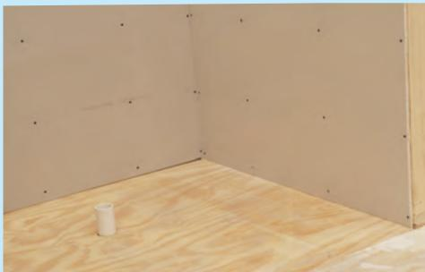
El subsuelo es estable y resistente, plano y nivelado, y cumple con los criterios de deflexión mínimos de L/360 según el IRC. Los sustratos estructurales de madera u hormigón están secos y son suficientemente resistentes teniendo en cuenta la carga viva y muerta.
