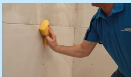
Si las juntas de los paneles de yeso están cubiertas con compuesto para paneles de yeso, se debe utilizar una imprimación de PVA antes de instalar la membrana wedi® S-DRY™. Si no hay compuesto, utilice una esponja húmeda para humedecer los paneles de yeso o CBU.
