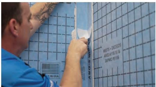
La membrane murale peut être installée avec wedi® S-DRY™ et wedi® S-DRY™ XL. Les joints peuvent être collés ou superposés, puis imperméabilisés et collés avec wedi® S-DRY™ SEAL.
