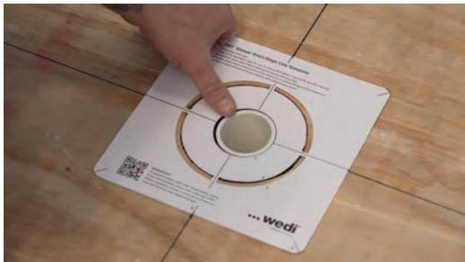
Facile à raccorder aux tuyaux d'évacuation coupés à ras de la surface du sous-plancher à l'aide du gabarit wedi® S-DRY™ Shower Drain/Slope line.
