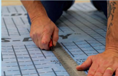
Découpez la membrane wedi® S-DRY™ à la taille souhaitée avant de mélanger la colle à prise rapide à l'aide de ciseaux ou d'un cutter.
