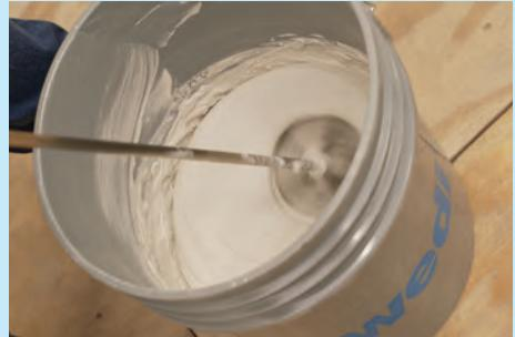
Les joints de plaques de plâtre naturellement effilés doivent être préparés à l'aide de wedi® PRO-SET™ ou d'un matériau de ragréage approprié afin de garantir que la membrane fine soit posée sur un support plat.
