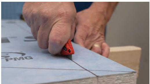
La découpe de la base S-DRY™ s'effectue à l'aide d'un simple cutter et d'une règle, sans générer de poussière. Les bases sont surdimensionnées pour plus de flexibilité.
