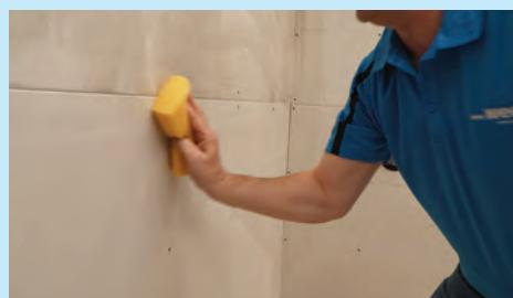
Si les joints des cloisons sèches sont recouverts d'un enduit pour cloisons sèches, un apprêt PVA doit être utilisé avant d'installer la membrane wedi® S-DRY™. En l'absence de mastic, humidifier la cloison sèche ou le panneau CBU à l'aide d'une éponge humide.
