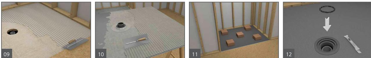
9. Limpie el subsuelo con una esponja húmeda para eliminar el polvo y la suciedad, y aplique una capa delgada de un adhesivo para baldosas modificado (ANSI 118.4 o superior) y pénelo con una llana dentada de ¼ pulg. x ¼ pulg. Las líneas de la llana deben aplicarse uniformemente y apuntar hacia el lado más corto de la superficie base.
