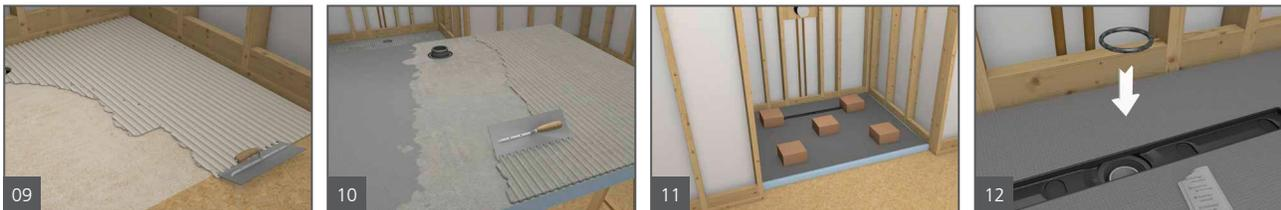
9. Limpie el subsuelo con una esponja húmeda para eliminar el polvo y la suciedad, y aplique una capa delgada de un adhesivo para baldosas modificado (ANSI 118.4 o superior) y pénelo con una llana dentada de ¼ pulg. x ¼ pulg. Las líneas de la llana deben aplicarse uniformemente y apuntar hacia el lado más corto de la superficie base.
