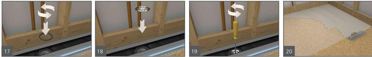
17. Inserte la contratuerca con el lado ranurado hacia arriba en la parte roscada de la abertura de la unidad de drenaje y atornille hasta que la parte superior de la contratuerca quede al ras del borde superior de la parte roscada de la unidad de drenaje. **Importante: Gire la contratuerca hacia la IZQUIERDA para insertar y atornillar a la posición al ras.**
