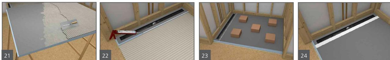
21. Extienda nuevamente el mortero cola sobre el lado posterior del módulo de extensión con una llana ranurada de ¼ pulg. x ¼ pulg. Aplane el mortero cola por toda la superficie de cemento del producto y, a continuación, alise el lecho de mortero cola creando canales que apunten en la misma dirección como se aplique en el contrapiso.
