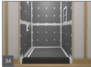
ajustar los soportes y las tapas de drenaje para que la altura coincida con la superficie de la loseta (el ajuste varía entre los modelos de 3/16 de pulg. de bajo a 1 pulg. de alto).
