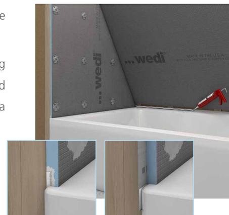
Cuando se instala el wedi® Building Panel en bañeras sin la brida de clavatura, utilice la cinta de sellado wedi para bañeras para impermeabilizar y asegurar la unión de transición en su parte posterior.
