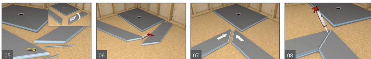
5. Voltee ambas extensiones y corte un canal de muesca de ½ pulg. x ½ pulg. en el borde de cada extensión donde se conectan ambas extensiones. Prepare y ajuste en seco un listón de panel de construcción de ½ pulg. en el canal de 1 pulg. x ½ pulg. formado por las dos extensiones donde se unen.
