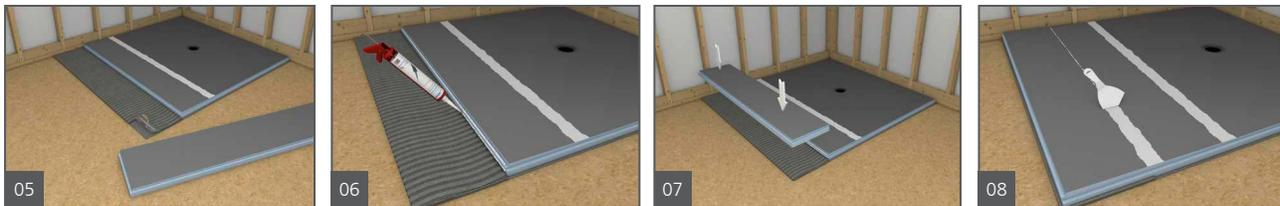
5. Aplique un lecho de mortero cola modificado en el panel de construcción con una llana ranurada.
