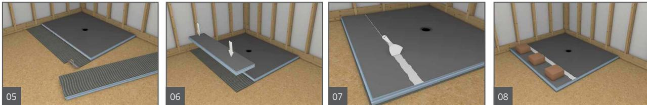
5. Aplique un lecho de mortero cola modificado en el contrapiso y en la contraparte inferior de la extensión con una llana de ranuras cuadradas de ¼ pulg. x ¼ pulg. en cada superficie. Asegúrese de que el mortero no contamine el sellador de juntas.
